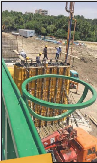
» بتن ریزی در مسیر زاینده رود پل فلزی ۵ تیر | مهتاب ترکی
